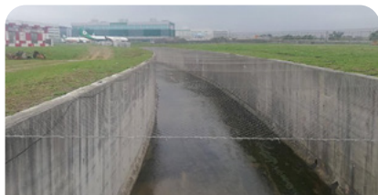
溝渠鋪設鳥網
