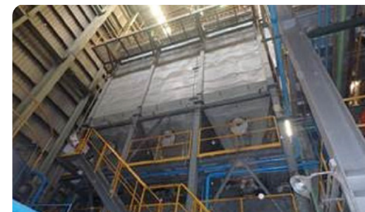
袋式集塵器漏斗破洞檢修
