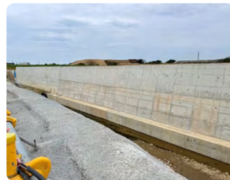
▲ 埔心溪新河道護岸施工
