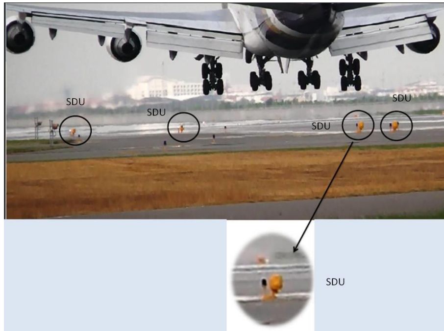
圖 77 FODetect 系統跑道安裝位置
